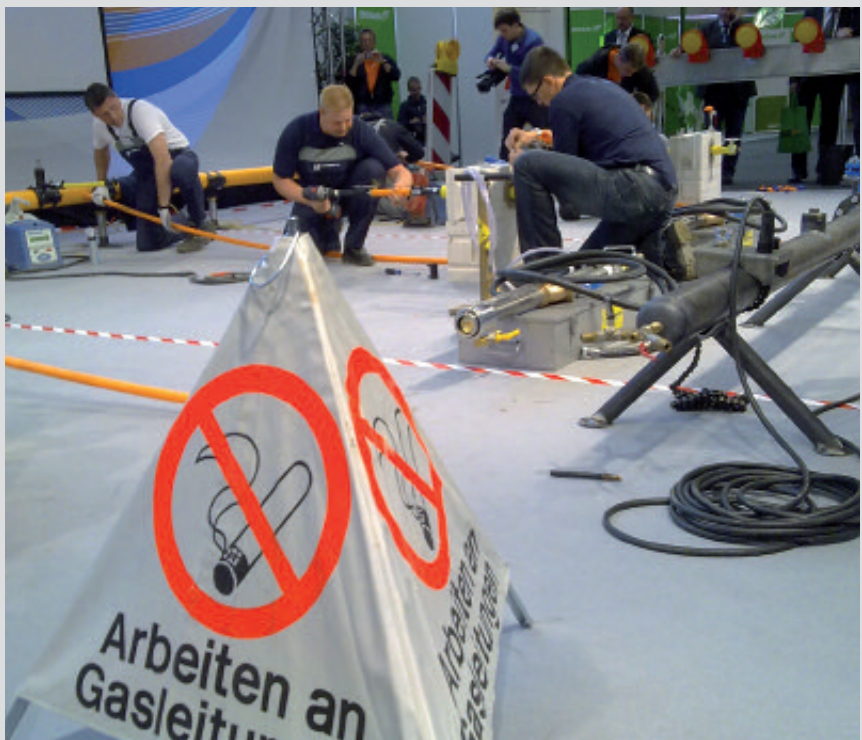
Sicheres Arbeiten an Gasleitungen zu vermitteln, spielte auch auf der „Pipetapping-Baustelle“ eine Rolle.
