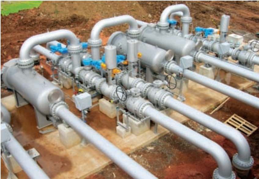
Abb. 2: Errichtung der Mischanlage Lauterbach, DP 100
